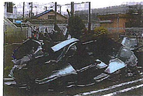
【図7】 上下の鋼板をネジだけで留める
